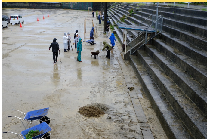
グラウンド側溝 作業中
