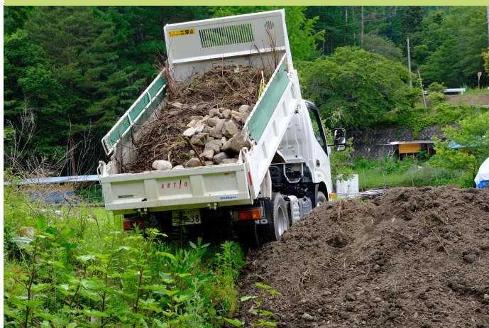
沢城湖土砂捨て場 作業中
