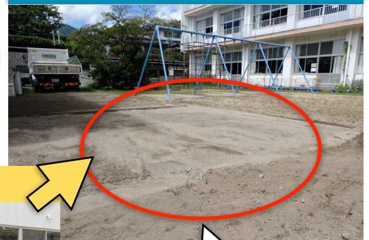
中庭砂場 作業後
