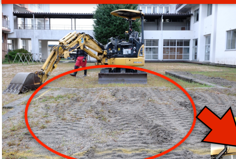
中庭砂場 作業前
