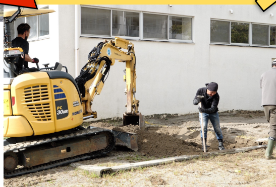
中庭砂場 作業中
